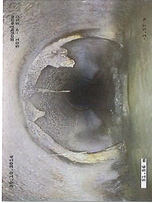
Calcaire aux joints et dépôts sur le radier
