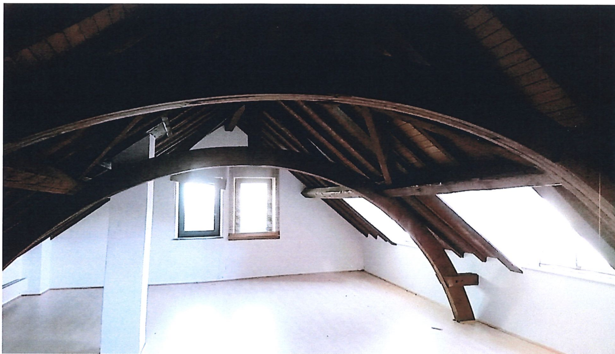
Charpente de la dépendance
