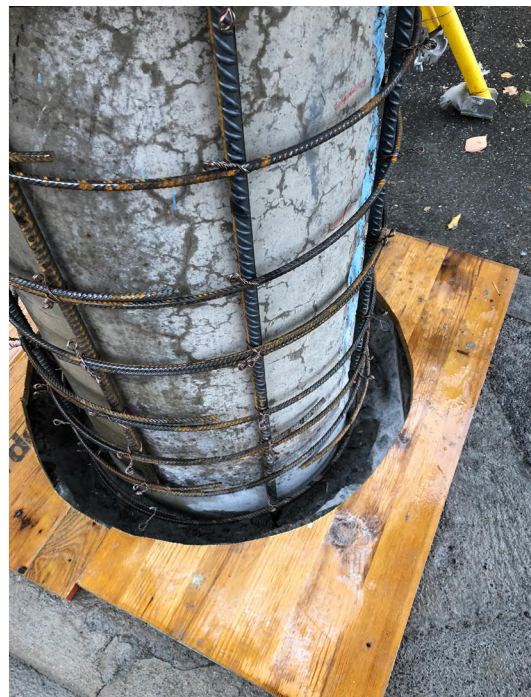
Figure 2-7 : Pile durant travaux de bétonnage
