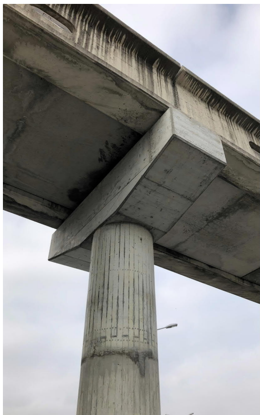
Figure 2-8 : Pile n°1 après travaux d'assainissement
