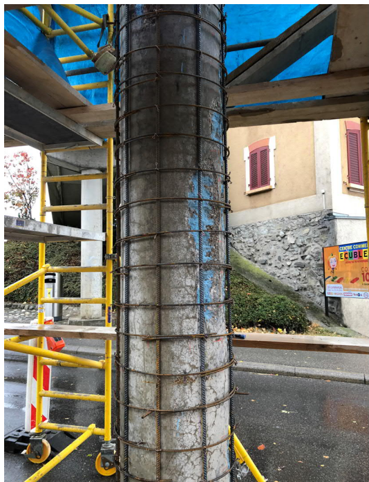
Figure 2-6 : Pile n° durant travaux de bétonnage
