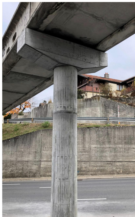
Figure 2-9 : Pile n°1 après travaux d'assainissement
