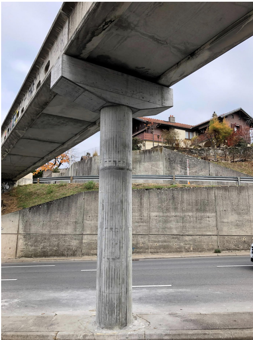
Figure 1-3 : Pile n°1 après travaux d'assainissement
