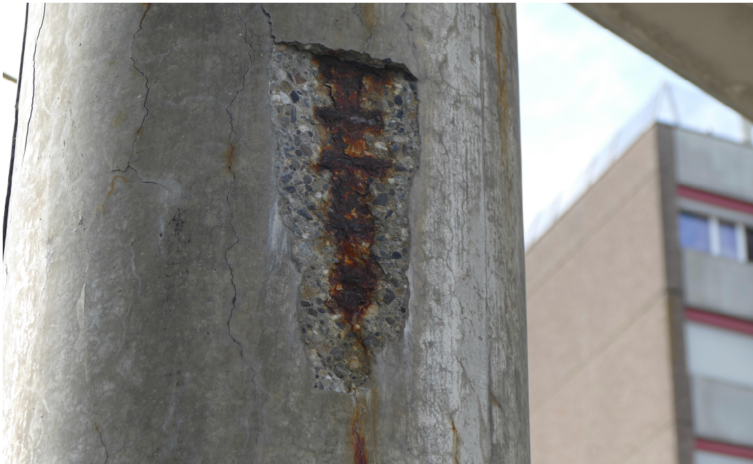
Figure 2-2 : Pile n°1 avant assainissement
