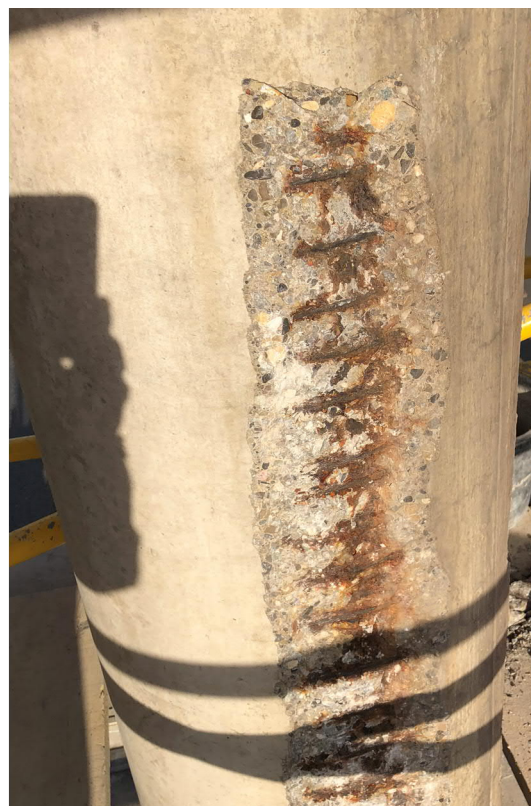
Figure 2-5 : Pile n°1 durant travaux de piquage
