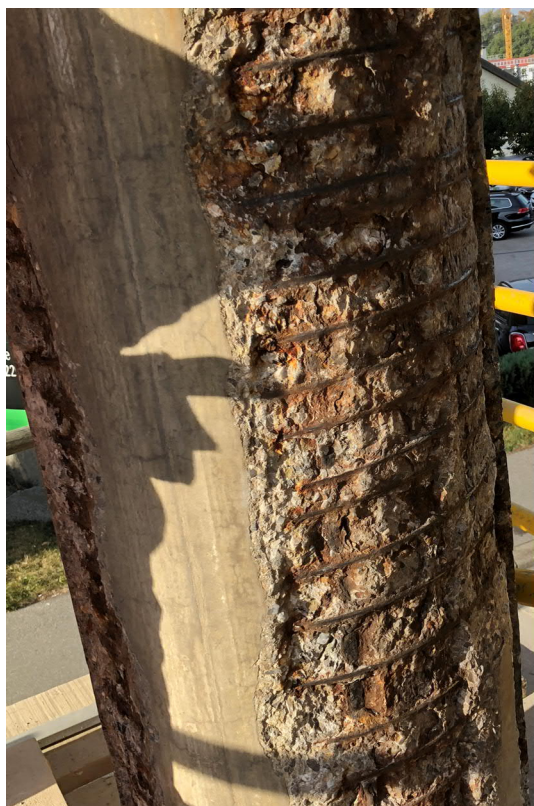
Figure 2-4 : Pile n°1 durant travaux de piquage
