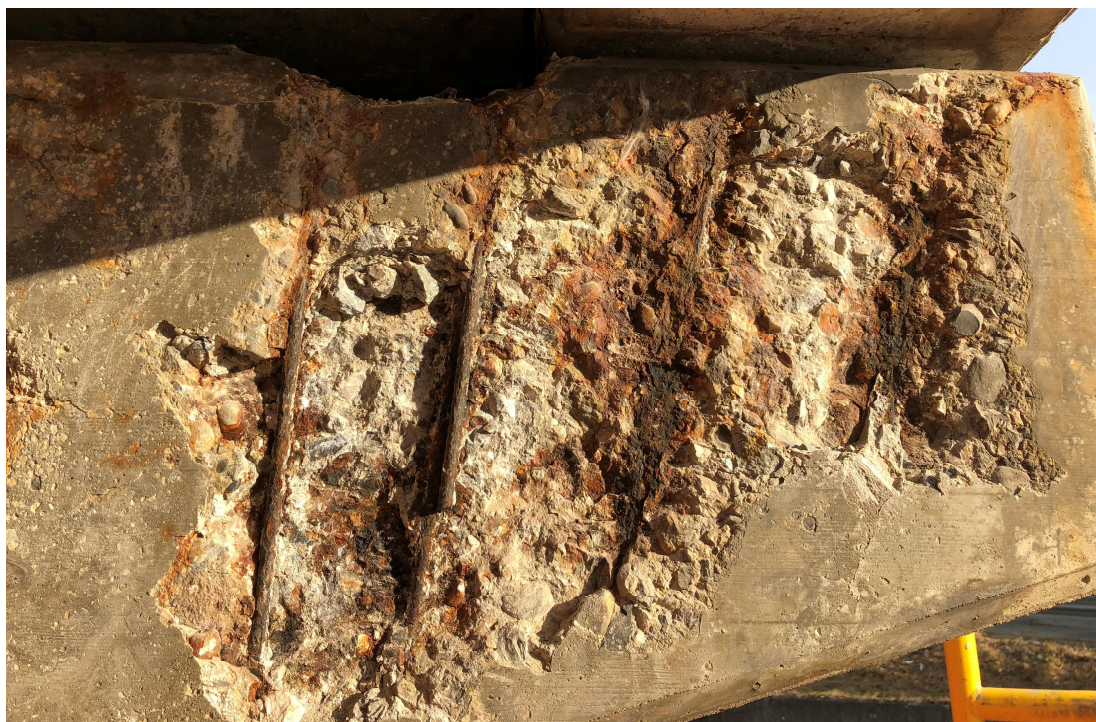
Figure 2-3 : Tête de pile n°1 durant travaux de piquage
