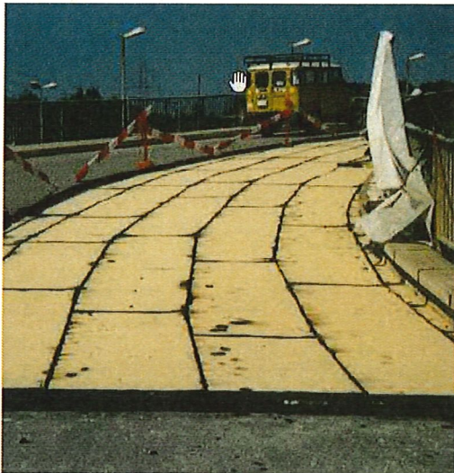
Figure 1-4 : Réfection du tablier
