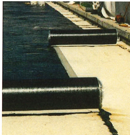
Figure 1-5 : Réfection du revêtement
