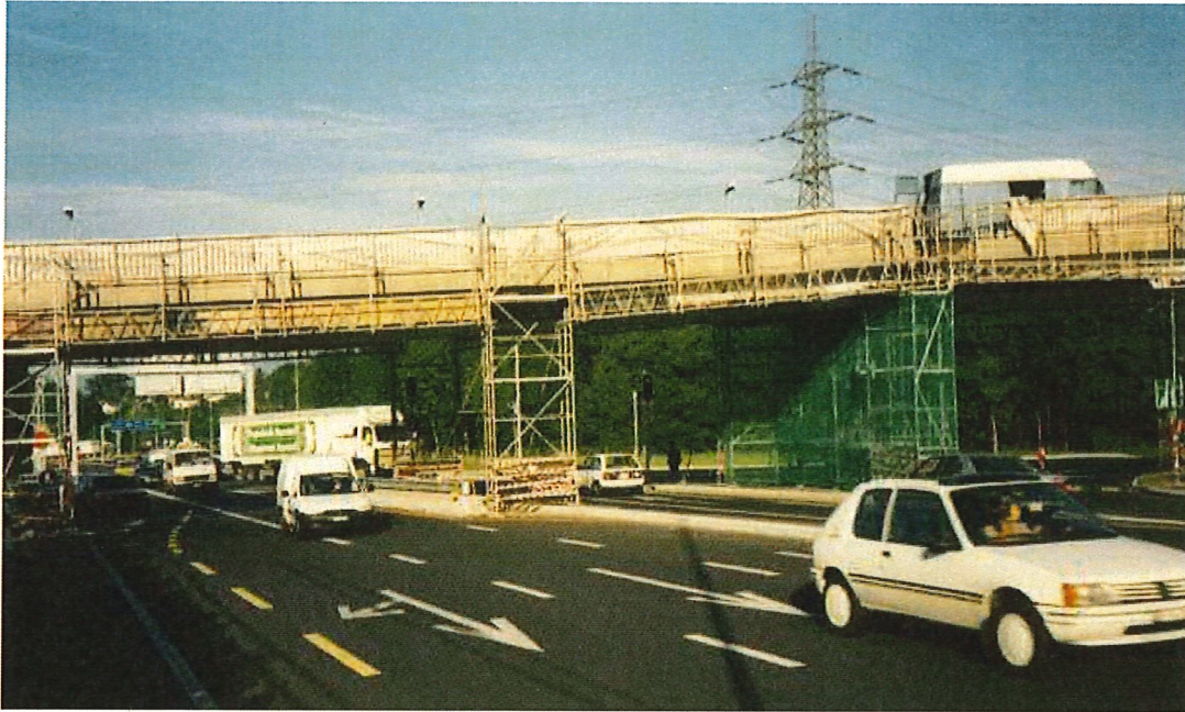
Figure 1-3 : Réfection globale de l'ouvrage
