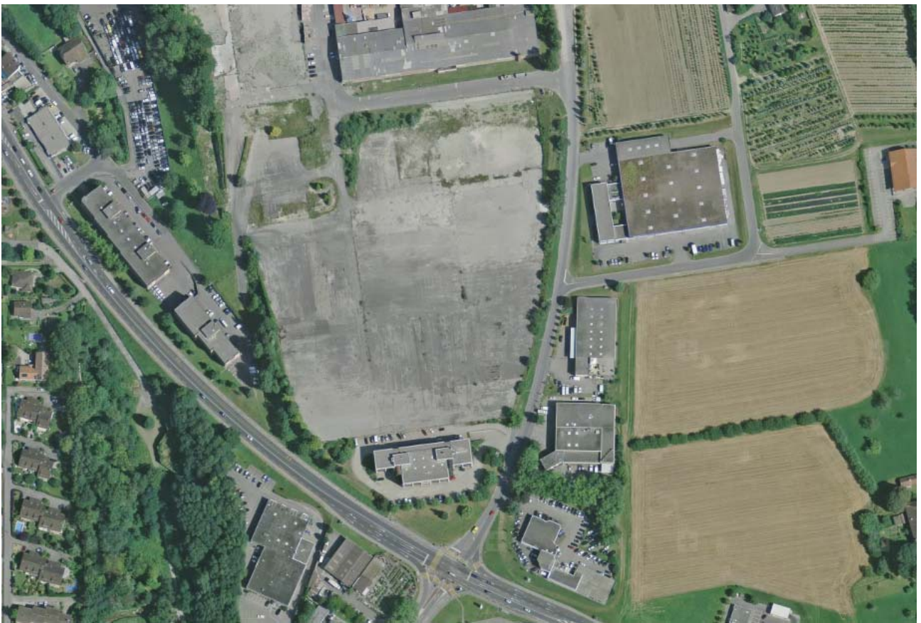
Vue aérienne avec au sud, le carrefour de Bois-Genoud qui se trouve à la limite communale avec Renens
