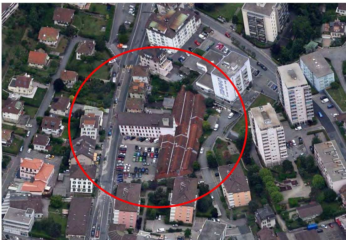
Photo aérienne du site avec au centre l'ancien bâtiment de l'entreprise Chicorée
